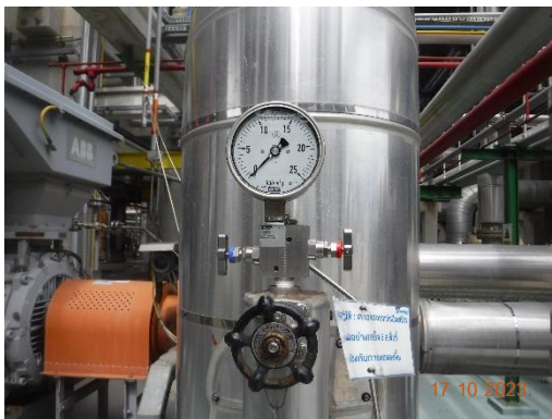
รูปที่ 3.54 Pressure / Temperature Indicator
