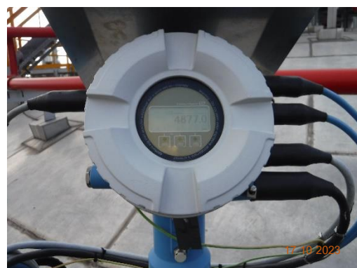
รูปที่ 3.59 อุปกรณ์วัดอุณหภูมิ และระดับของเหลว ในถังเก็บโพพิลีนออกไซด์
