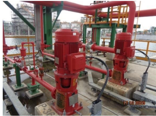
รูปที่ 3.47 เครื่องสูบน้ำดับเพลิง (ต่อ)
