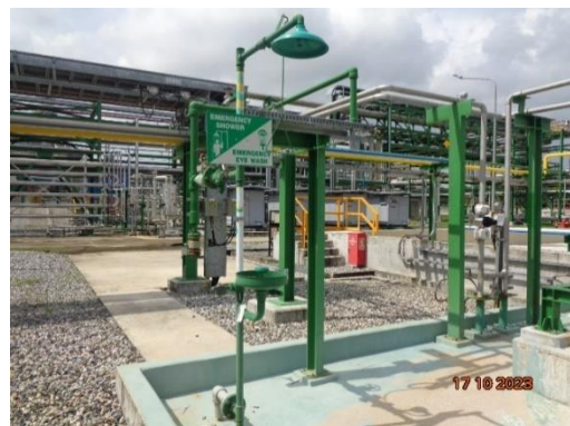
รูปที่ 3.43 อ่างล้างตาและร่างกายในบริเวณกระบวนการผลิต
