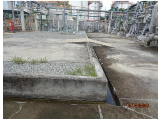
รูปที่ 3.57 คันกันล้นรอบบริเวณบึงสูบน้ำโพพิลีนออกไซด์
